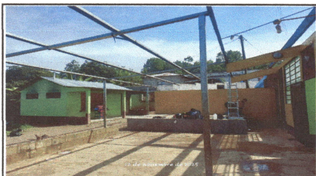
Foto 3: Desistalación de techo y cubierta del exterior, escenario y patio del centro educativo.
