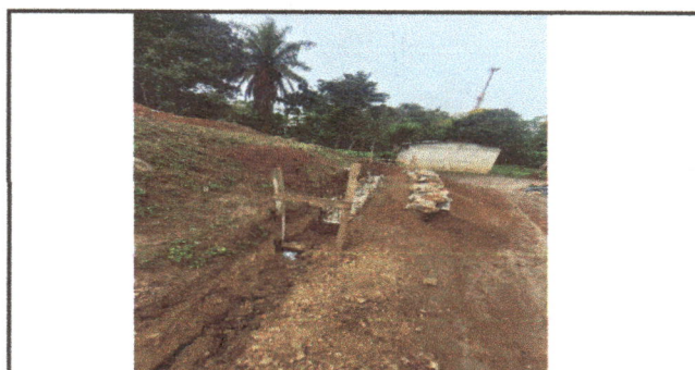
Foto 6: Reparación y seguimiento de muro de contención
