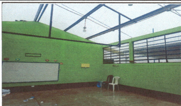
Foto 1: Desistalación de techo de una de las aulas
