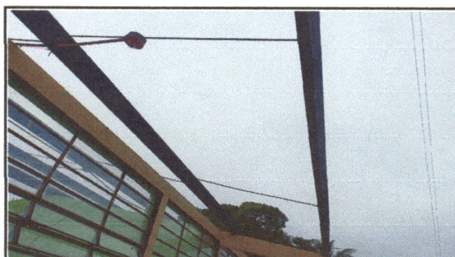
Foto 4: Mantenimiento de estructura de techo
