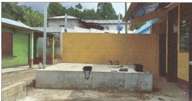
Foto 5: Torta de piso rustico a escenario y repello de paredes
